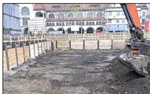
Abb. 4. Schichtenweiser Abtrag, verpflichtend bei baubegleitender KMR
